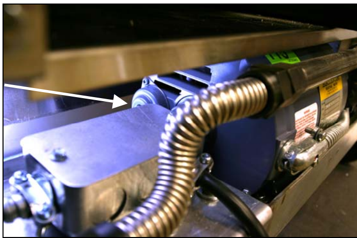
Commutateur de réarmement de la pompe du filtre (flèche)
